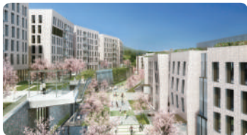
기숙사 E-house 완공(2016)
